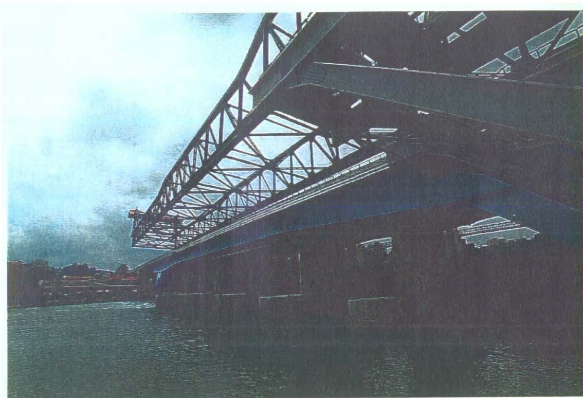
Autostrada del GRA di Roma — Ponte sul fiume Tevere
