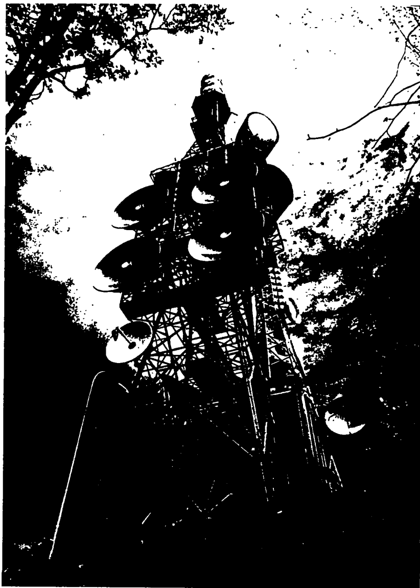
Insieme di antenne della stazione RAI di M. Venda.
