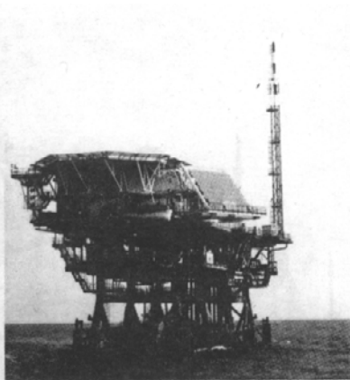
Italia, Mare Adriatico. La piattaforma Luna B impiega l'energia solare per l'alimentazione di alcuni sistemi di sicurezza. L'esperienza dell'Eurosolare, unica industria fotovoltaica in Italia, è il segno dell'attenzione che l'ENI rivolge a ogni segmento del settore energetico.
