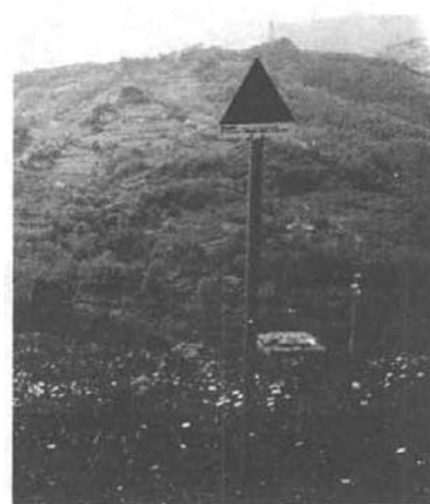
Italia, Liguria. Successivamente alla posa dei gasdotti viene effettuata un'accurata operazione di ripristino in modo da riportare il terreno nelle condizioni ottimali
