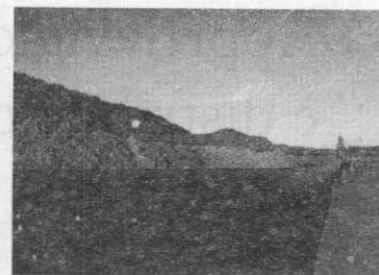
Tunisia. Operazioni di posa del gasdotto Transmediterraneo.
