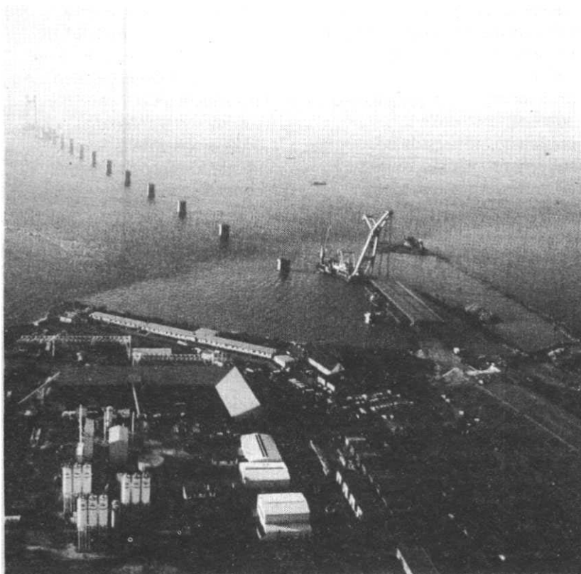
Il ponte sullo Storebaelt, in Danimarca, realizzato dalla Coinfra.
