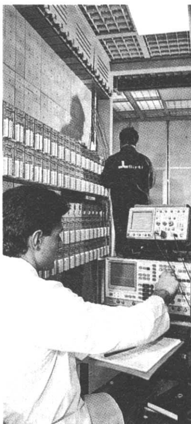
Lavori di installazione effettuati dalla Sirti presso una centrale telefonica numerica di Roma.
