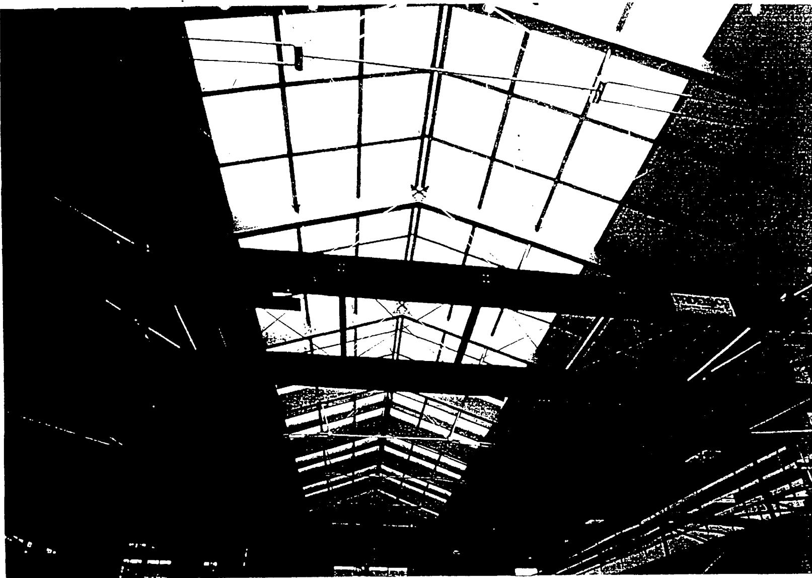
SAVE Aeroporto Marco Polo S.p.a.-Nuova Aerostazione - Zona 1 copertura centrale ATI: Grandi Lavori Fincosit S.p.a. - ABB Sae S.p.a.
