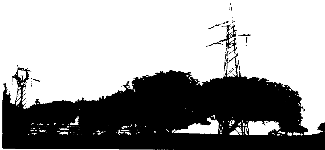
Elettrodotto a 150 kV. Stazione Ragusa - Cabina Primaria Santa Croce Camerina, realizzato con sostegni di tipo unificato ENEL e con conduttori All/Acc da 503 mm 2
