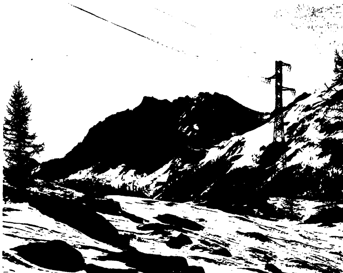
Nuova linea a 15 kV Perreres-Pousset (AO).
