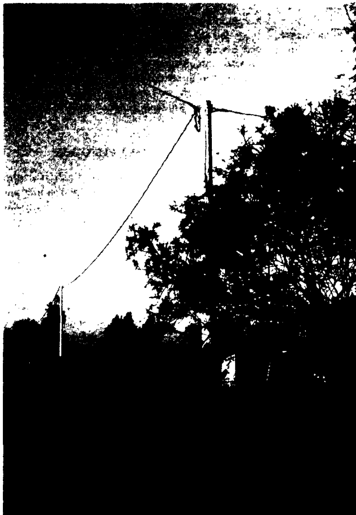
Elettrificazione rurale in agro di Guspini (CA). Linea in cavo cordato
